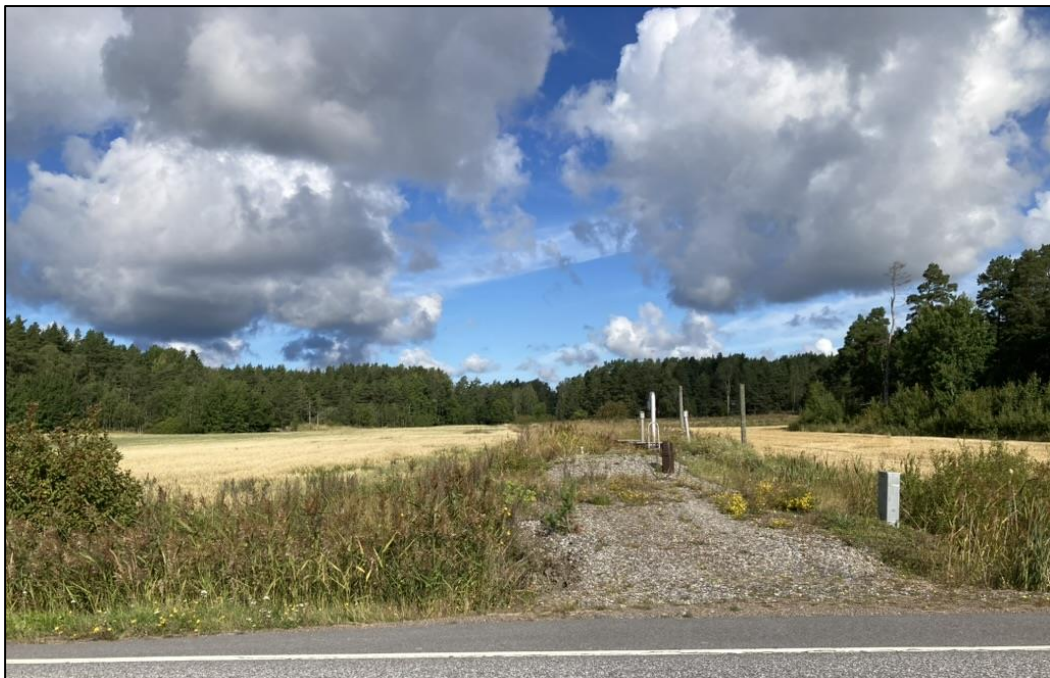
Siirtoviemärin laitteistoja alueen itärajalla
