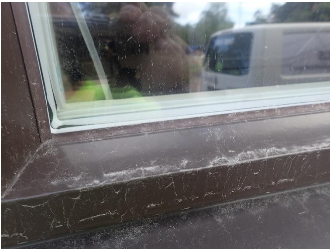
Ulkopuite on tyydyttävässä kunnossa.
