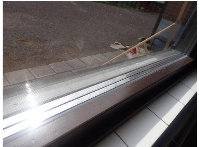
Osa ikkunoista on kiinteitä.
