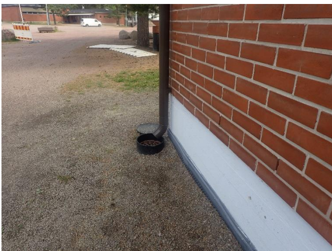
Rännikaivo ja salaojakaivo rakennuksen kulmassa.
