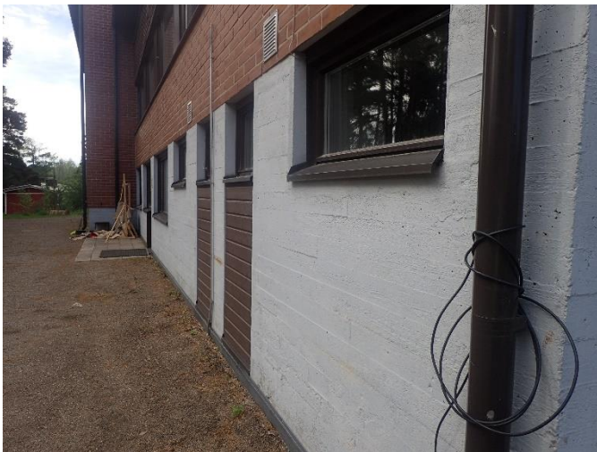
Julkisivun alaosa on betonia.
