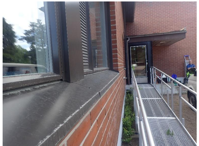
Vesipellit viettävät rakennuksesta pois päin.
