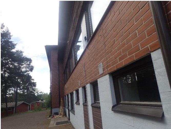
Julkisivun alaosa on betonia.
