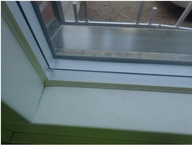
Osa ikkunoista on kiinteitä.
