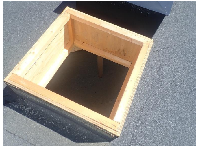
Kattoluukku yläpohjaan.
