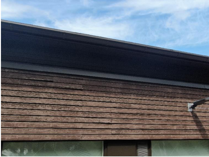
Itäpuolen julkisivun yläosa on puuverhoiltu.
