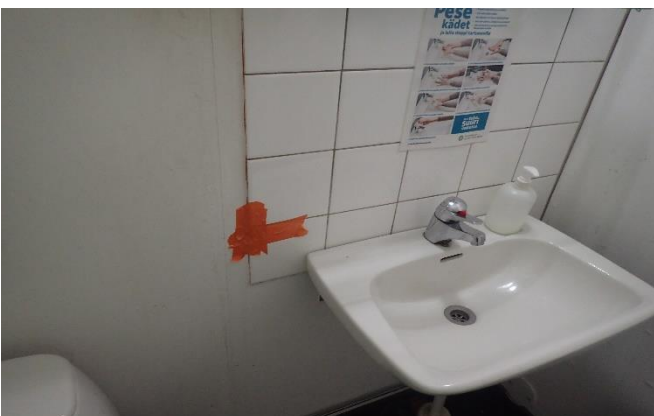
Näyte 5 otettiin yläkerran wc:n välitilalaatasta, laastista ja sauma-aineesta.
