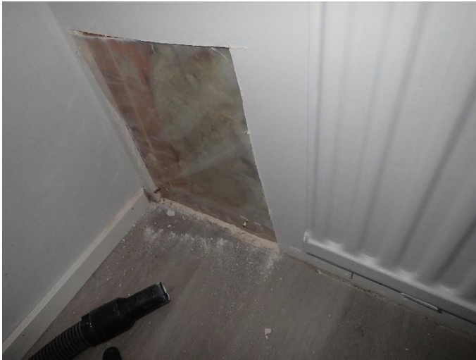
Lämmönjako on toteutettu pattereilla.
