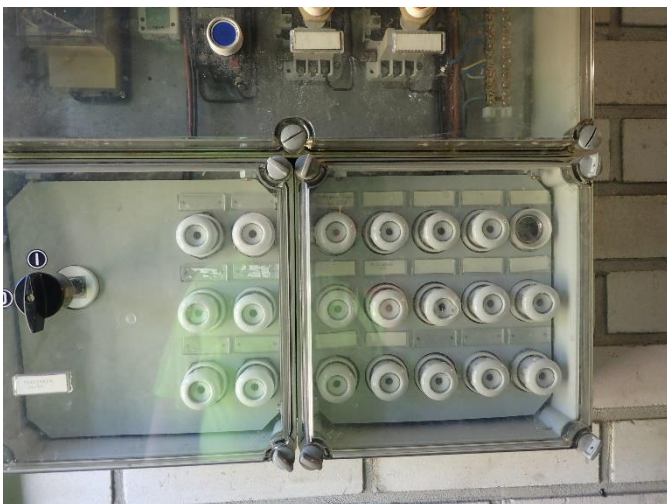
Lämmönjakohuoneen sähkötaulu.
