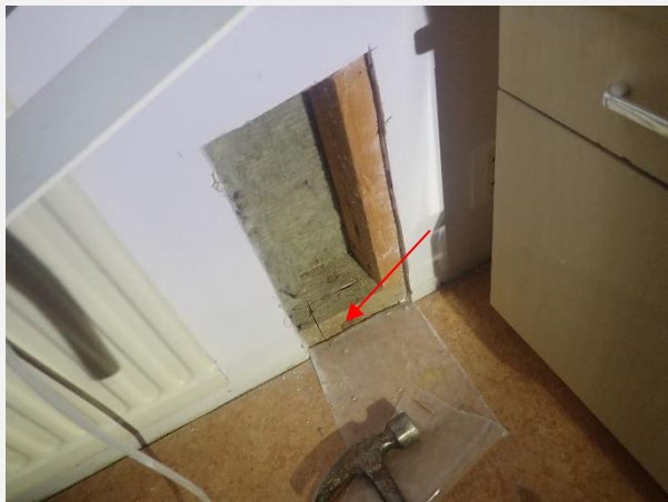
Näyte PS4, otettiin huoneiston B5 makuuhuoneen ulkoseinärakenteesta
