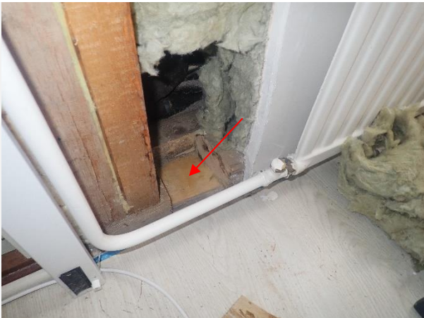
Näyte PS1, otettiin huoneiston A4 olohuoneen kohdalta ulkoseinärakenteesta.
