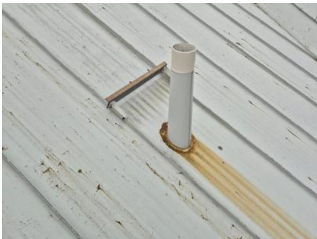
Viemäriputkien läpivientien juuret ruostuvat voimakkaasti
