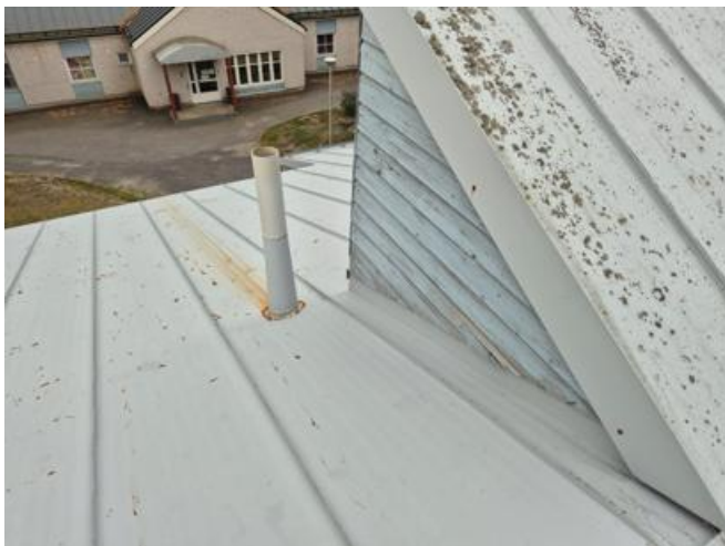
Viemäriputkien läpivientien juuret ruostuvat voimakkaasti
