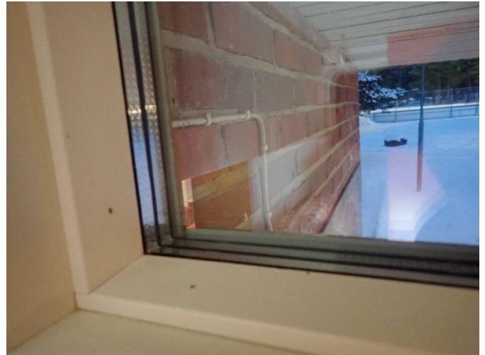
Osa ikkunoista on kiinteitä.
