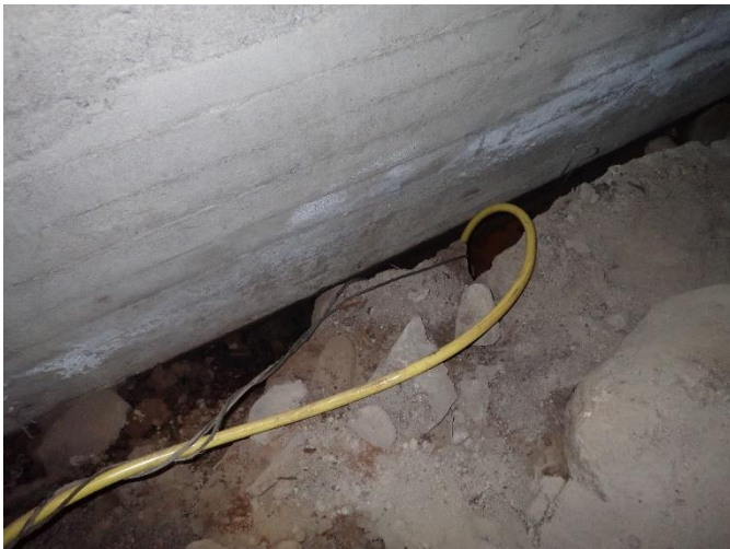
Tilaan kertyy vettä, jota poistetaan uppopumpulla.
