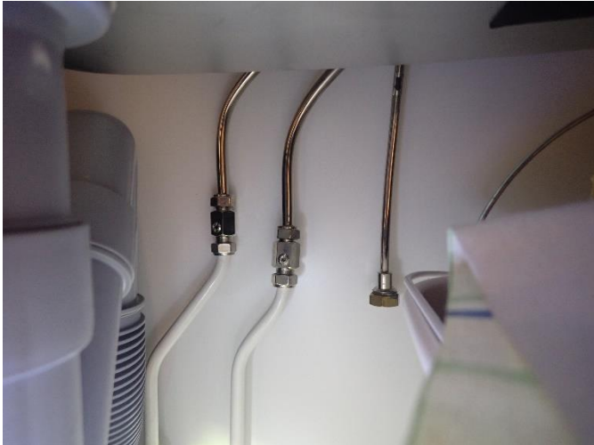
Käyttöveiputket ovat kuparia. Putken päähän on suositavaa asentaa tulppa.
