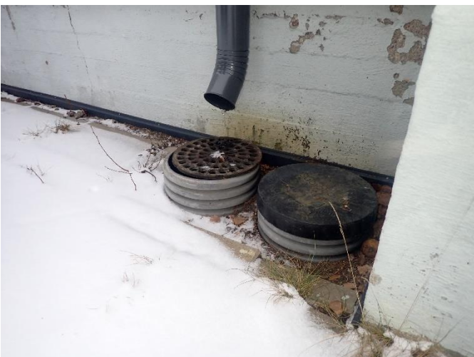
Ränni- ja salaojakaivo.
