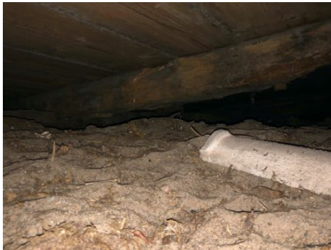
Tuvan hiekkalattiarakennetta itäisivulla
