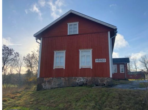
Luoteisnurkalla kalliopinta johtaa pintavesiä nurkan obi
