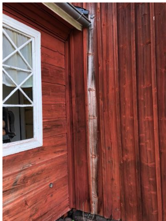
Kuistin katolta on valunut vedet päärungon seinää pitkin vuosia ennen vesikourujen asentamista
