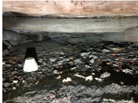
Maitoahuoneen alapohjan rakennetta. Kuvasa näkyvät kelluvana rakennuksen poikittaissuuntaisesti asennetut lattianiskat, jotka on asennettu rakennuksen pituussuuntaisesti asennettujen haltijahirsien päälle. Kuva otettu pohjoisen suunnasta.
