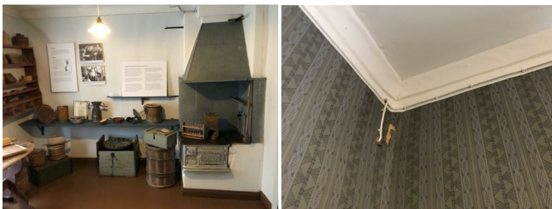
Maitokamarin eteläseinän pinkopahvitusta ja tapetointia
