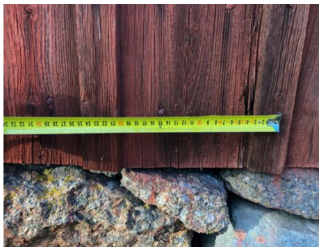
Itäisivun ulkoverhouksen alareunan paikallisia vaurioita
