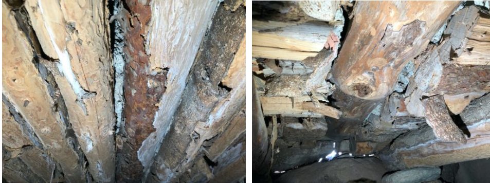
Salin ja Volter Kilven huoneen alapohjassa savella on tehty haljaspuolikkaiden yläpintaan tuulensuojakerros.
