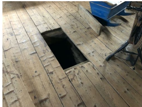
Tuvan kuurilattiaa, keskellä näkyy kellari
