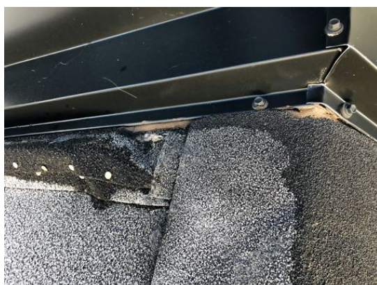
Pohjoisen piipun silikonitiivistystä ja vuotoherkkä kohta kolmioriman ja pellityksen saumassa
