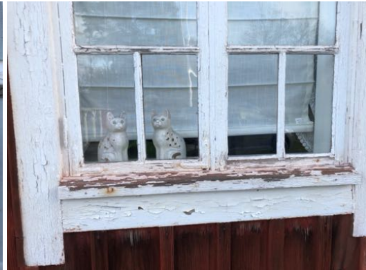
Postihuoneen vasemman puitteen vasen alalasi on rikki. Puitteet on maalattu paikallaan kiinni karmeihin, maalia on paksult. Salin länsiseinän luoteisnurkan ikkunan ulkopuolen maali- ja kittipinnat kaipaavat huoltoa.
