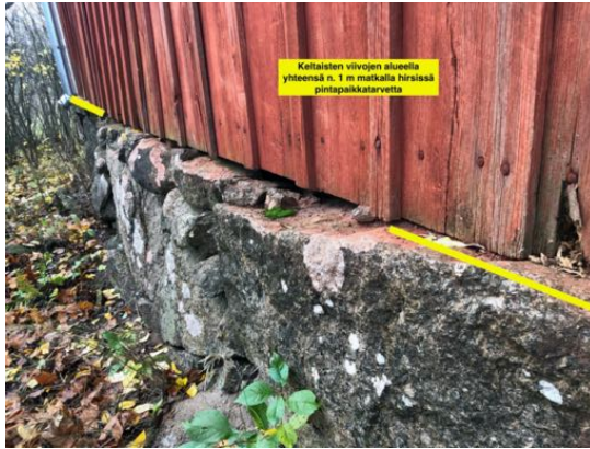
Itäisivun paikallisia labovaurioita
