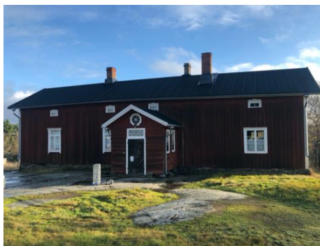
Rakennus lännestä kuvattuna
