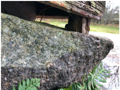
Kuistin luoteisnurkan pystypilari on edelleen kiven päällä
