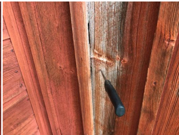
Kuistin katolta on valunut vedet päärungon seinää pitkin vuosia ennen vesikourujen asentamista
