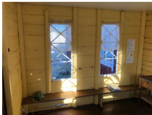
Reunimmaisat pystypilarit, oviaukon ympärillä olevat ja sivuilla keskimmäiset pystyt ulottuvat katosta perustuksiin
