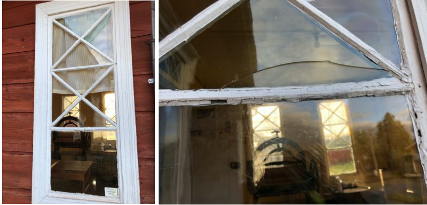
Pohjoissivun särkyneitä lasiruutuja
