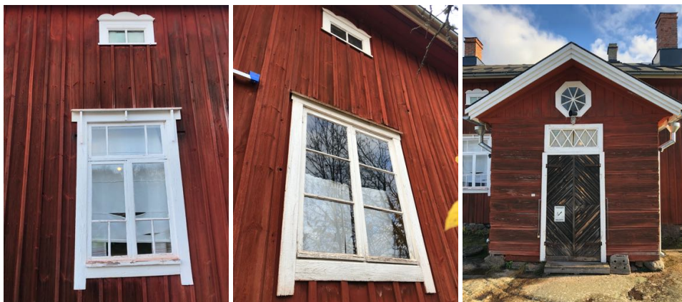
Postihuoneen ikkuna ja vintin haukkaikkuna, joka on asennettu yllä haukkaikkuna sisäpuoli ulospäin
