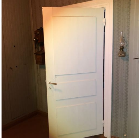
Postihuoneen ja tuvan oven pintapeilirakennetta
