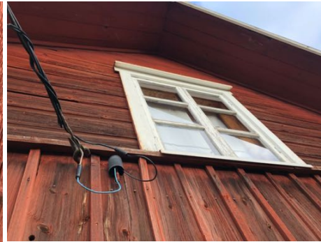
Eteläpäädyn päätykolmion keilaponttipanelointia
