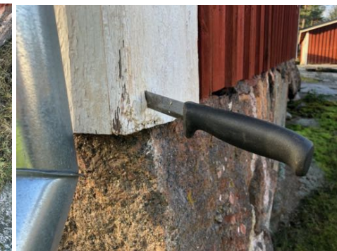
Luoteisnurkan nurkkalautoitus on alapäästään labo, samoin koillisnurkan nurkkalautoitus
