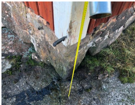
Luoteisnurkan nurkkalautoitus on alapäästään labo, samoin koillisnurkan nurkkalautoitus
