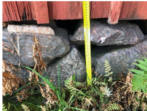
Länsisivulla kivijalan korkeus matalimmillaan n. 300 mm
