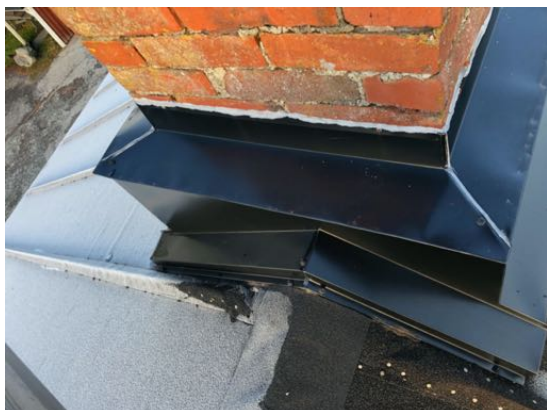
Pohjoisen piipun silikonitiivistystä ja vuotoherkkä kohta kolmioriman ja pellityksen saumassa
