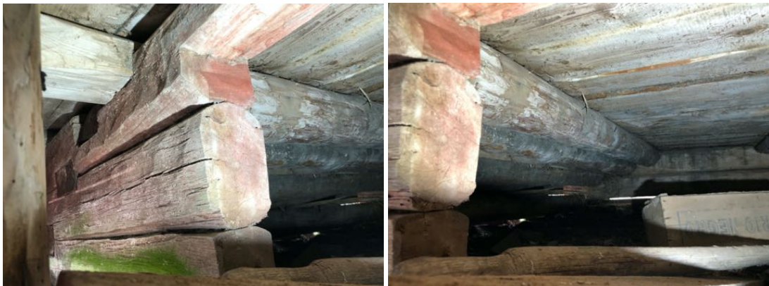
Kuistin lattiarakenteena on hirsiarikka
